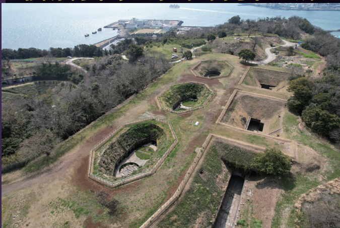
千代ヶ崎砲台跡整備後空撮
